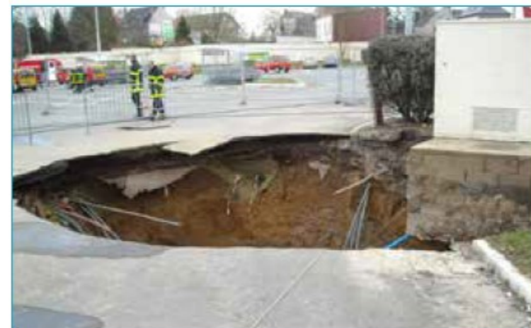
Illustration 1.27 : Effondrement de chaussée, Bapaume (62) [crédit BRGM, sd]
